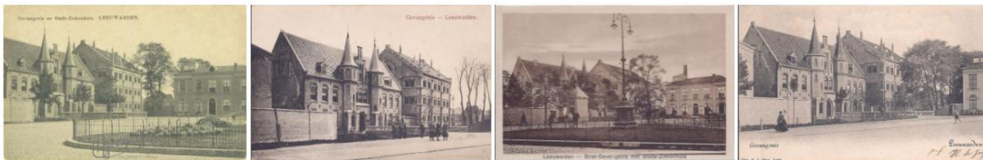
De bijzonder Strafgevangenis en Huis van Bewaring zijn in verschillende tijdsdelen gebouwd.
