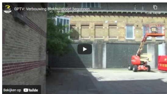
GPTV-verbouwing "DeBlokhuysPoort" begonnen
