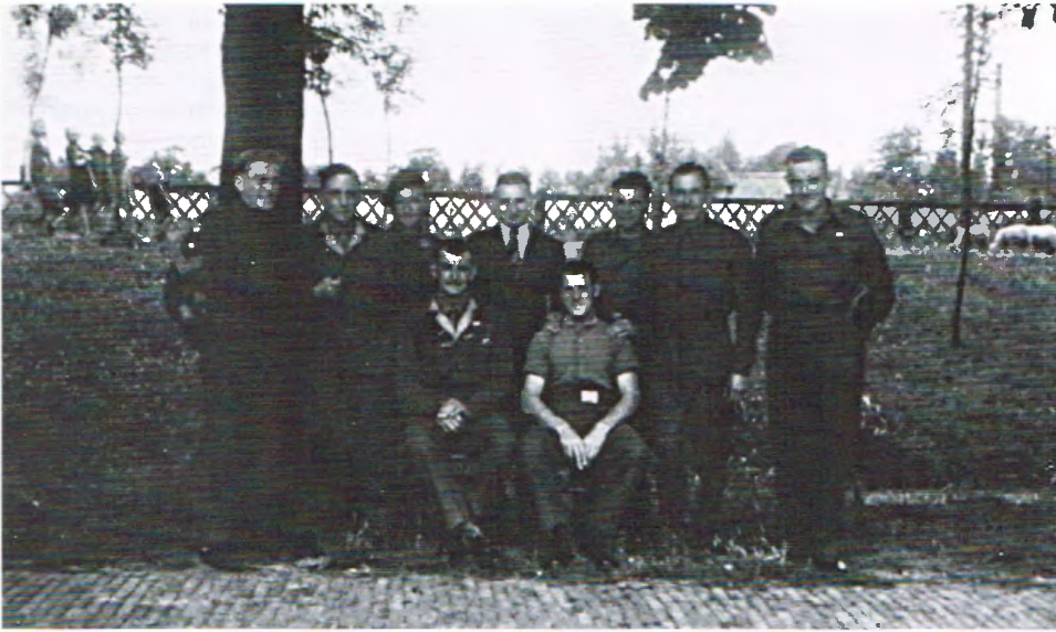
De Engelse engineers. De 'Bailey' bruggenbouwers die o.a. de brug over de Tjonger bouwden. Hier gefotografeerd voor hotel Speckman in Wolvega (nu afgebroken).
