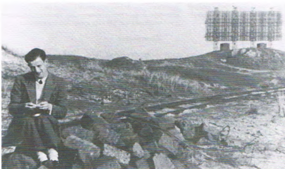
Deze radar peil- antenne stond in de oorlogsjaren in de omgeving van De Helder/Huisduinen. De afgebeelde antenne is een veel- heid van Freya-anten- nes, een z.g. Wasser- man-combinatie.
