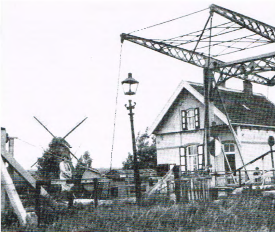
Schoterzijk. Zo was het. De niet meer bestaande sluis- wachterswoning van Toorn, die zwaar werd beschadigd.
