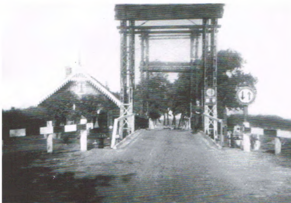
De 'Bailey'-brug bij Oudeschoot, als vervanger van de door de Duitsers opgeblazen Schoterbrug.
