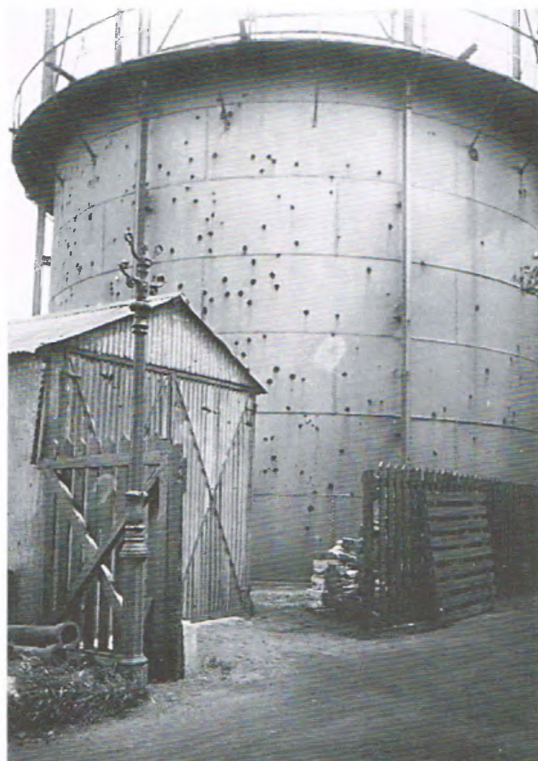
Opname van de grote gashouder van de gemeentelijke gasfabriek te Wolvega na de beschieting vanuit de lucht op 15 augustus 1944.
